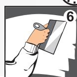
Шпатлевку БОЛАРС Финишная Super нанесите стальным шпателем на основание слоем до 2 мм. Для получения более толстого слоя допускается шпатлевание в несколько слоев. Последующий слой нанесите после полного высыхания предыдущего, предварительно прогрунтовав. При грунтования тщательно выжимайте валик о лоток для предотвращения размокания шпатлевки.
