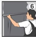
В случае необходимости применения штукатурных маяков, установите их параллельно другу на расстоянии 15-20 см меньше ширины правила. "Набросайте" штукатурку мастерком или нанесите кельмой слоем от 2 до 30 мм. При механизированном нанесении приготовленный раствор наносят методом машинного набрызга. Нанесенный слой разровняйте с помощью кельмы или правила.
