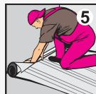
После образования поверхностной пленки уложить покрытие и хорошо притереть, особенно в области стыков. Сварку стыков производить не ранее 48 часов, полная нагрузка на поверхность возможна через 72 часа после приклеивания.
