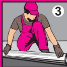
Приклеиваемое покрытие должно быть предварительно раскроено и выдержано в развернутом виде при комнатной температуре.
