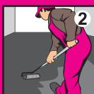
Поверхность обработать грунтом, подходящим для вашего типа основания («укрепляющим» – для оснований с нормальным водопоглощением, либо «глубокого проникновения» – для сильно впитывающих оснований). Для гарантированного качества сцепления материалов рекомендуем использовать грунты ТМ БОЛАРС.
