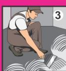
Перед началом работы клей тщательно перемешайте. Нанесите клей зубчатым шпателем или кистью на основание слоем до 2 мм. Для приклеивания материалов а) для ковров и других материалов с гладкой обратной стороной лучше пользоваться шпателем с мелкими зубцами б) для ковров и других материалов с шершавой обратной стороной - шпателем с грубыми зубцами в) для керамических плиток - шпателем с прямоугольными зубцами.
