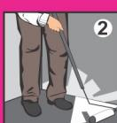
Сильно впитывающие поверхности (пено-газоблоки, бетон, кирпич, гипсовые и цементные основания, ГКЛ, ГВЛ, старая плитка) обработать грунтом, подходящим для вашего типа основания — «укрепляющим», либо «глубокого проникновения». Для гарантированного качества склеивания материалов, рекомендуем использовать грунты ТМ БОЛАРС.
