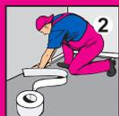
2 Тщательно заделайте все отверстия и трещины в полу, чтобы предотвратить утечку выравнивающей смеси и усадку затвердевшего пола. По периметру помещения установите изоляционный шов с помощью кромоочной ленты.
