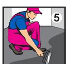
5 При толщине слоя свыше 5 мм рекомендуется устанавливать точечные маяки для контроля уровня заливки пола. Наливной пол «Финишный СВ 1010» разлейте на поверхности полосами шириной 50-100 см. При необходимости распределите широким шпателем или раклей для лучшего выравнивания.
