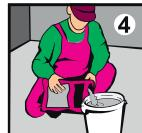
Для подготовки раствора залейте водопроводную воду комнатной температуры в чистую ёмкость из расчёта 0,32 - 0,35 л воды на 1 кг сухой смеси.
